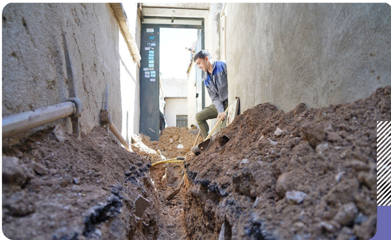
اجرای شبکه فاضلاب به روش فاینانس جاری در منطقه سعدی شهر شیراز
